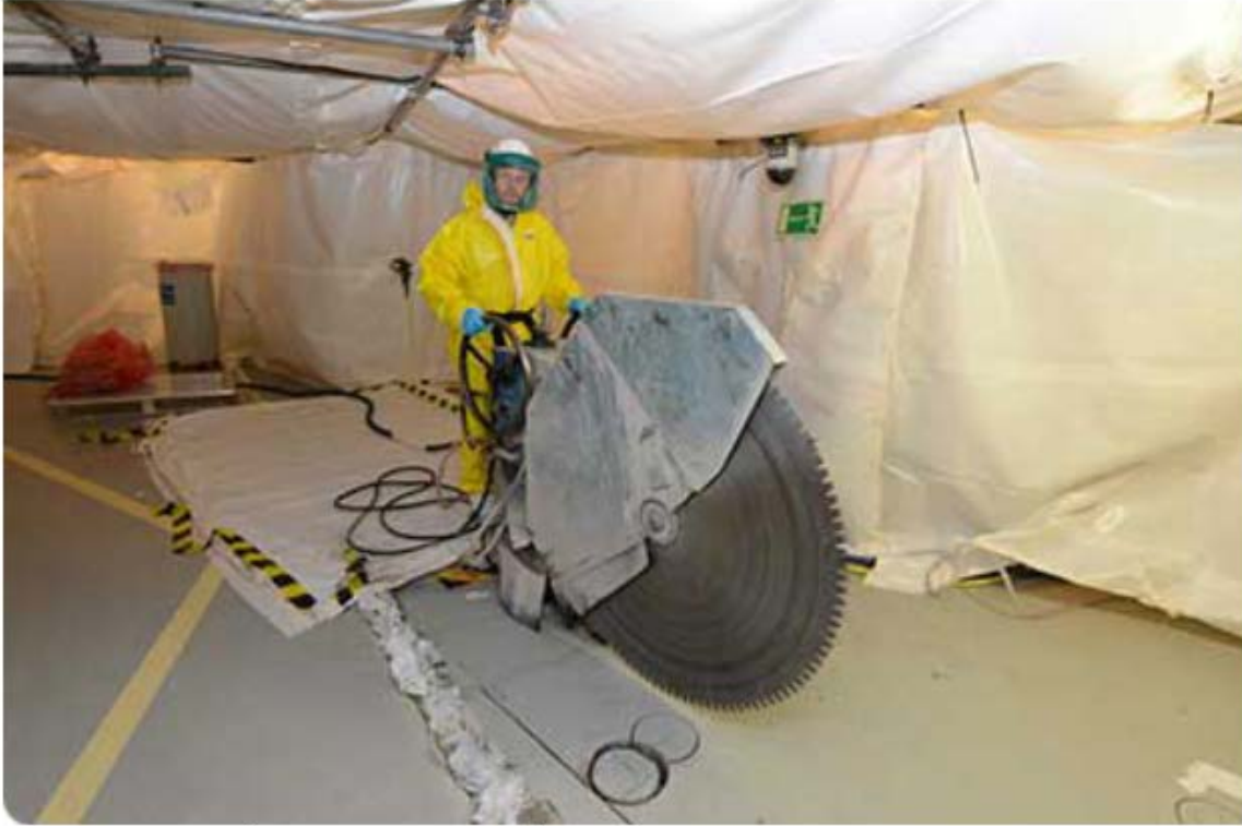
För att komma åt att undersöka plåten måste betongen tas bort.
