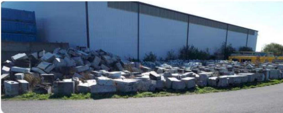
Stora mängder betong togs upp från inneslutningens golv. Efter 40 år som golv i containment är betongen fortfarande så ren att den har friklassats och nu ligger bakom avfallsbyggnaden.
